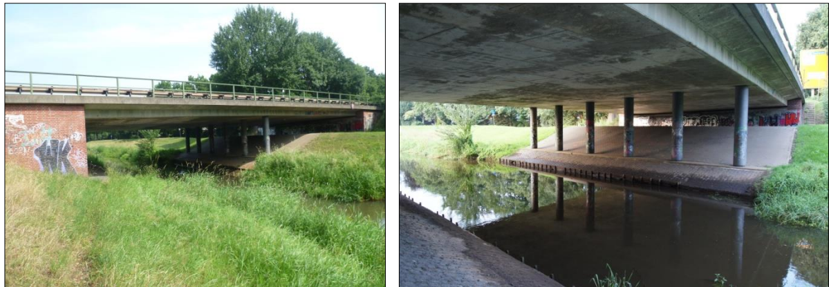
Abbildung 10: Bestehendes Bauwerk 443 (Fotos: K. Otte & C. Neuhaus (2015))
