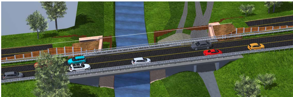
Abbildung 8: Bauphase 2, Verkehr auf fertiggestelltem Teilbauwerk
