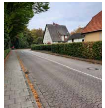
Abb. 48 bis 51 (v.o.n.u.): Die Bebelstraße (links die Rückbaufläche des Parkhauses); Fehlende Raumkante an der Lutherstraße; Blick durch den Logemannsgang auf die ehemalige Disko an der Friedrich-Ebert-Allee; Sanierungsbedürftiger Straßenabschnitt Am Vorwerk
