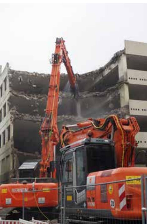
Abb. 73: Abriss des ehemaligen Hertie-Parkhauses Quelle: Stadt Delmenhorst
