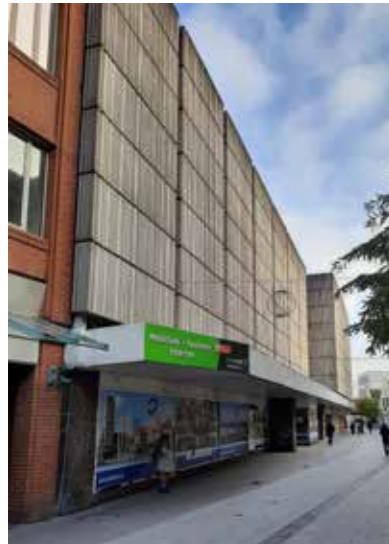
Abb. 52 bis 55 (v.o.n.u.): Verwildertes Grün am Vorwerk-Parkplatz; Der Parkplatz am kleinen Vorwerk, Stellplätze auf dem Schweinemarkt; Fassade des ehemaligen Hertie-Kaufhauses
