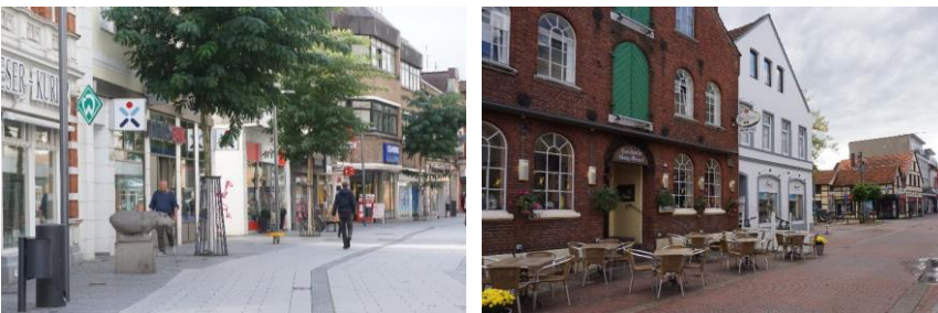
Sanierter Straßenbelag in der Lange Straße und Gastronomie in historischer Bausubstanz Quelle: cima, 2022
