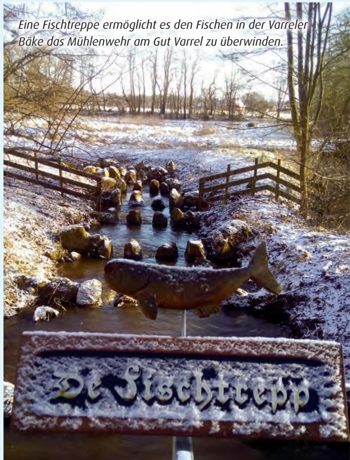
*Eine Fischtrepp ermöglicht es den Fischen in der Varreler Bäche das Mühlenwehr am Gut Varrel zu überwinden.*
